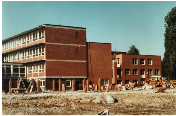
Neubau von hinten
