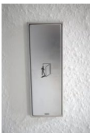
Abbildung 23: Türschalter zum Öffnen der Automatiktüren im Wohnprojekt Lübbecke
